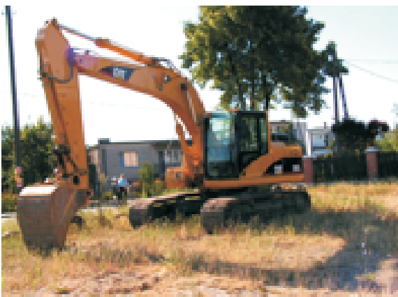
Sprzęt gotowy do pracy
